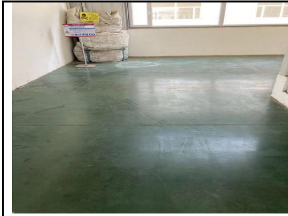
图 4-16 一般固废暂存间
