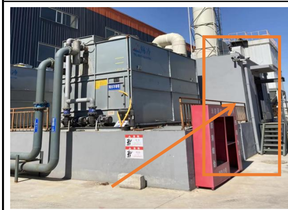
图 4-12 电解槽冷却循环水系统（新水）
