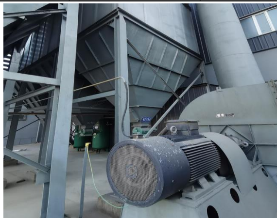
图 4-14 设备减振基础
