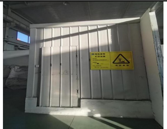
图 4-17 危险废物暂存间
