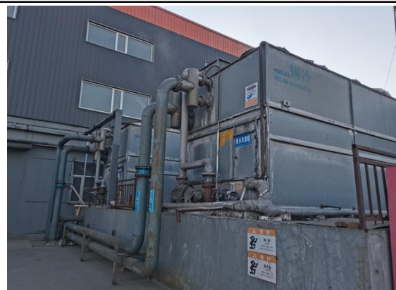
图 4-13 整流柜等冷却循环水系统（纯水）
