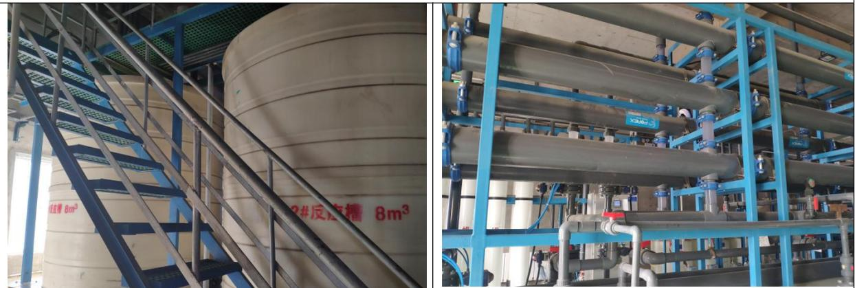
图 3-7 除硬除硅反应池+管式微滤膜单元
