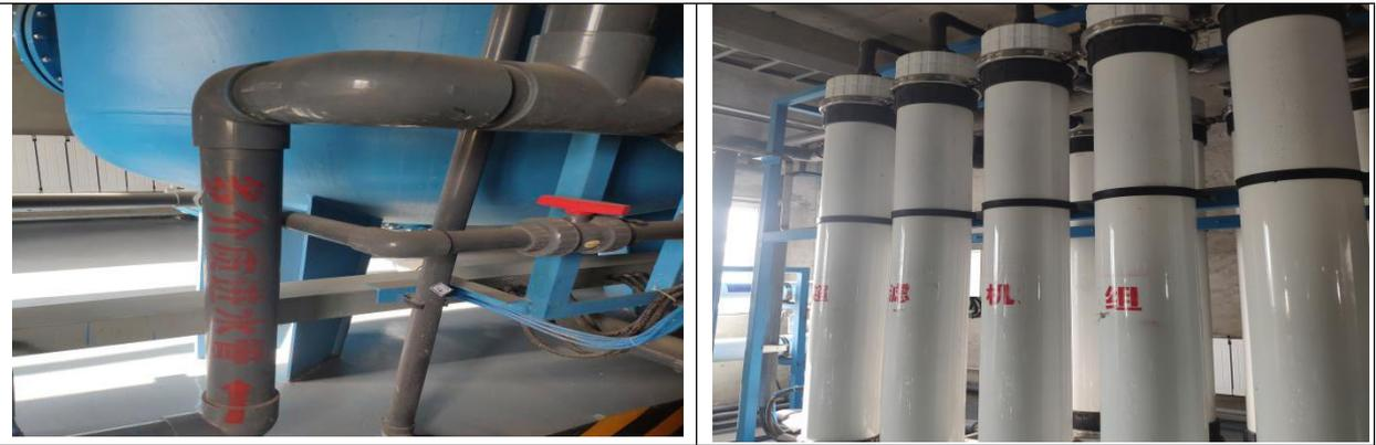
图 3-5 多介质过滤器+外压式超滤单元
