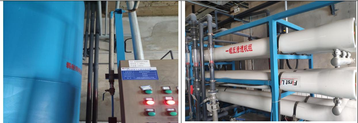
图 3-6 弱酸软化树脂塔+一级反渗透单元
